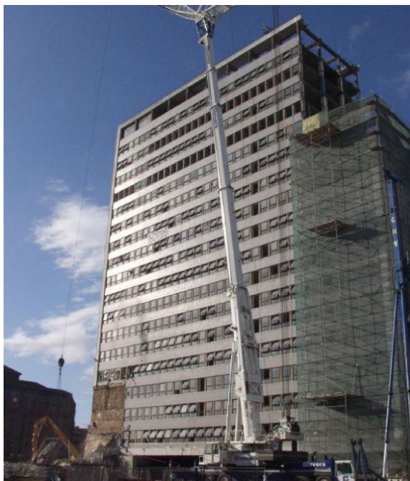
Η προετοιμασία του κτιρίου
