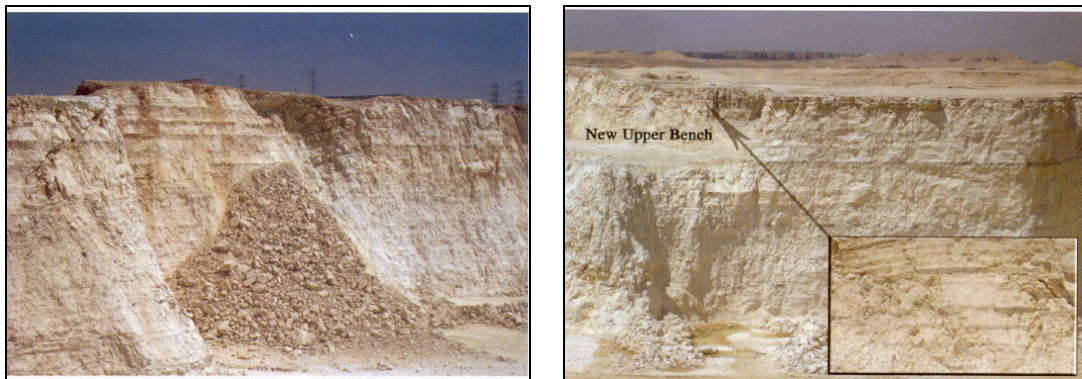
Εικόνες από τις βαθμίδες του λατομείου με έντονη την εμφάνιση ρωγμών & διακλάσεων
