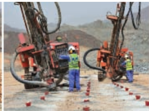
Διάτρηση για δημιουργία τάφρου με ελεγχόμενη ανατίναξη Πηγή : http://gulfrack.com
