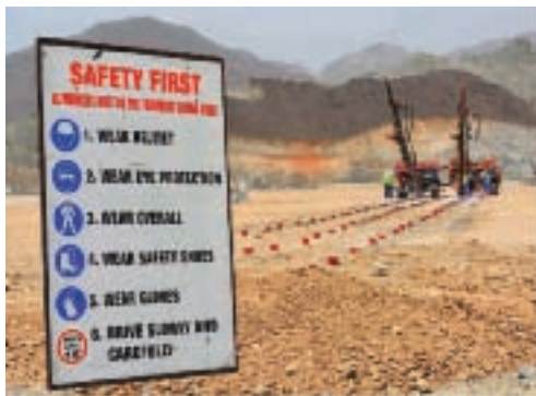
Διάτρηση για δημιουργία τάφρου με ελεγχόμενη ανατίναξη Πηγή : http://gulfrack.com
