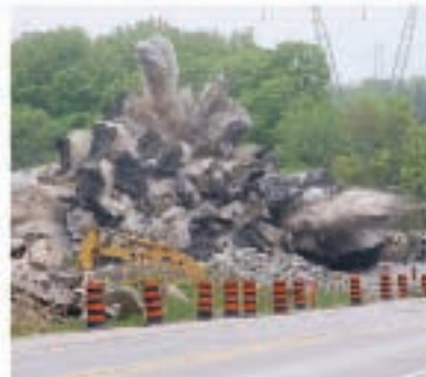
Βίαιη εκτίναξη τεμαχίων Η πιο συνηθισμένη αιτία πρόκλησης ατυχημάτων από ανατινάξεις Πηγή : http://lowvelder.co.za
