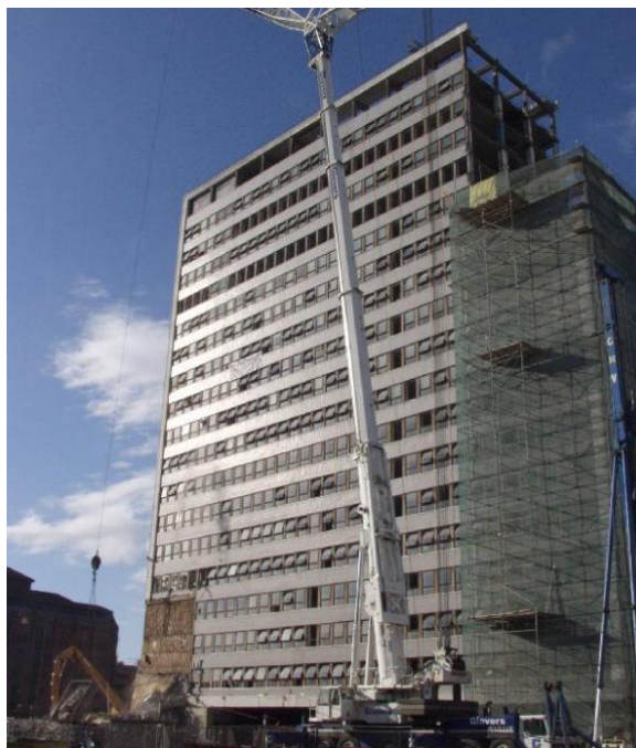
Η προετοιμασία του κτιρίου
